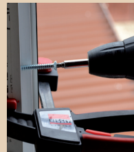
Anschließend wird der neue Rahmen mehrfach sicher verschraubt und abgedichtet.
