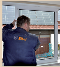
Der alte Fensterflügel wird ausgehängen.
