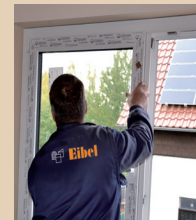
Als letztes wird der Flügel eingehangen und justiert.
