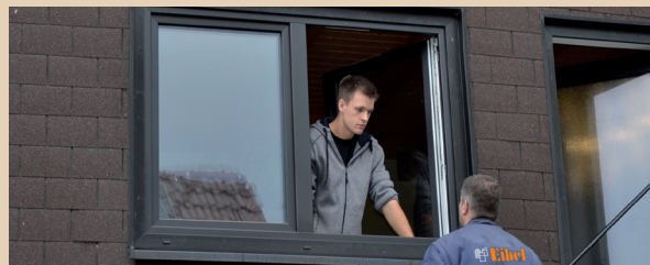
Anschließend wird der neue Rahmen mehrfach sicher verschraubt und abgedichtet.
