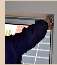
Auf den alten Rahmen wird ein Dichtband angebracht.
