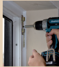
Danach wird der Beschlag des alten Fensterrahmens abgeschraubt.
