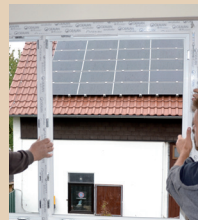
Der neue Rahmen wird auf den Alten aufgesetzt.
